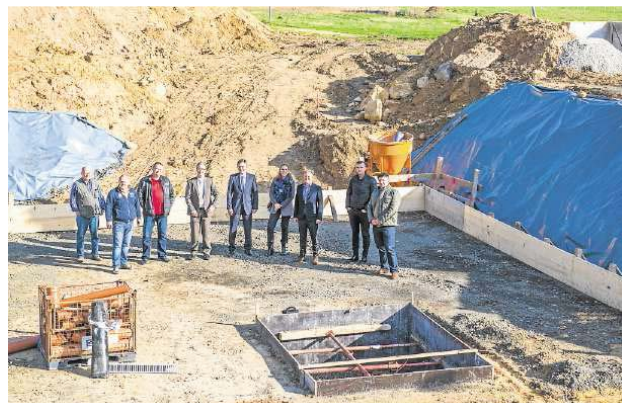
Die erste Baugrube ist ausgehoben: bauWerk-Geschäftsführer Rainer Velmeden (3.v.r.) mit Investoren, Finanzierern und Baufirmen, die an dem Projekt „MonroePark“ beteiligt sind. Foto: Frieze
